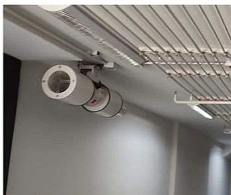
ภาพที่ 2-6 พัฒนาระบายอากาศที่มีตัวกรองอากาศ
