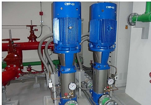
ภาพที่ 2-9 ห้องเครื่องสูบน้ำดับเพลิง และน้ำประปา อยู่ในสภาพดีไม่ชำรุดเสียหาย
