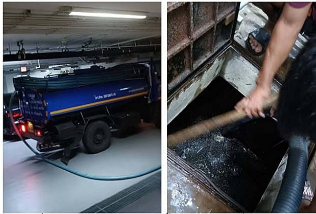
ภาพที่ 2-43 ดูแลรักษาระบบบำบัดน้ำเสีย ดูตะกอนที่บ่อเก็บตะกอน
